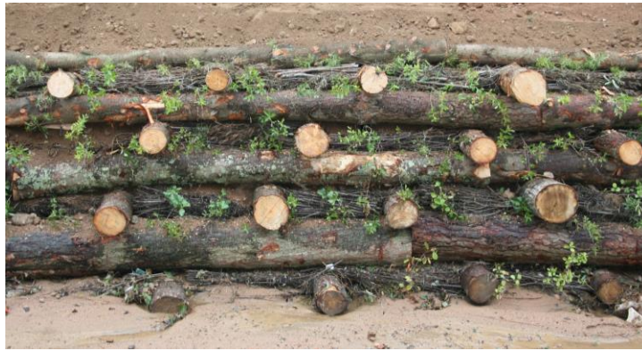
Figura 6. Detalle constructivo y ejemplo de entramado Krainer
