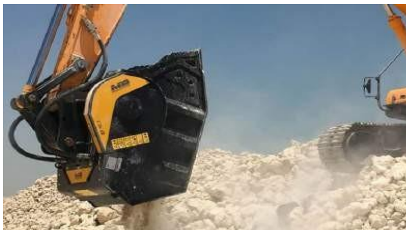
Figura 8. Ejemplo de trituración mecánica de hormigón
