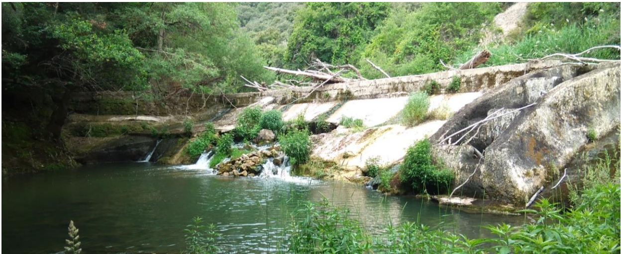
Figura 2. Estado actual de la presa Arquijas
