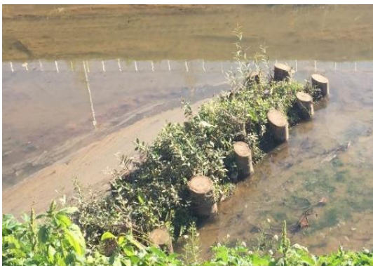
Palissada amb troca d'arbustives just acabada d'instal·lar.
