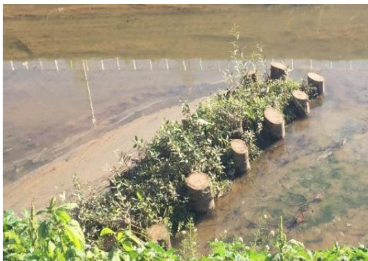
Empalizada con madeja de arbustivas recién instalada.
