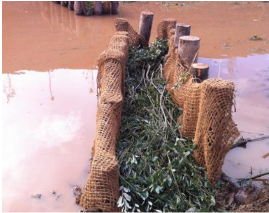
Empalizada con madeja de arbustivas en proceso de construcción
