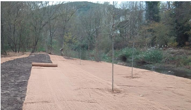
Figura 16 Plantación de árboles en el margen izquierdo durante la ejecución
