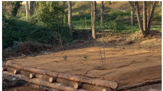
Figura 19 Plantación de árboles y arbustos dispersos en el margen derecho una vez terminada la actuación.
