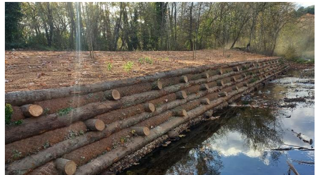
Figura 5 Margen izquierdo con entramado después de la actuación.
