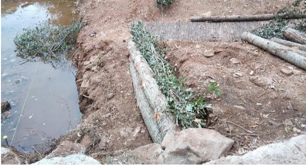
Figura 14 Construcción de la empalizada soterrada.
