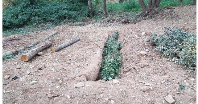
Figura 15 Fajinas vivas instaladas en la parte posterior de las empalizadas.
