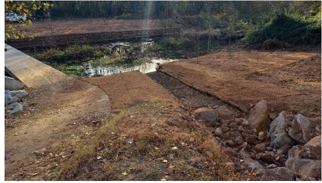
Figura 11 Cuneta drenante después de la actuación
