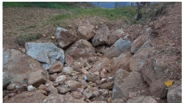
Figura 9 Estructura de disipación de energía de la escorrentía después de la actuación
