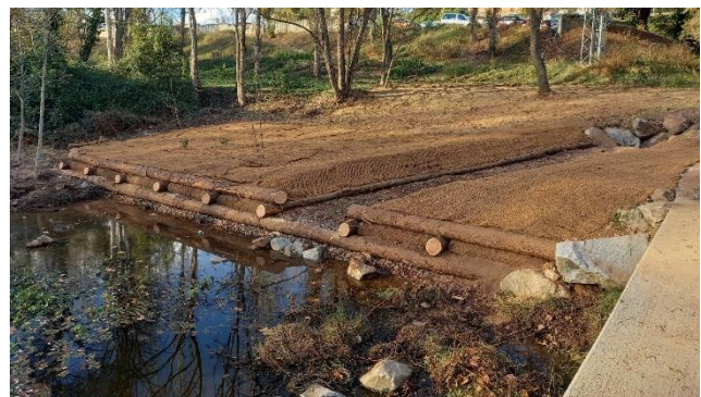
Figura 13 Margen derecho con el entramado después de la actuación
