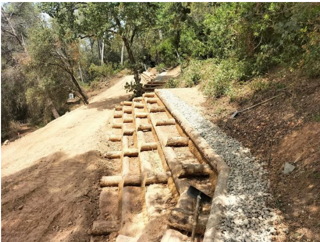
Figura 8 Construcción del acabado superior del entramado.
