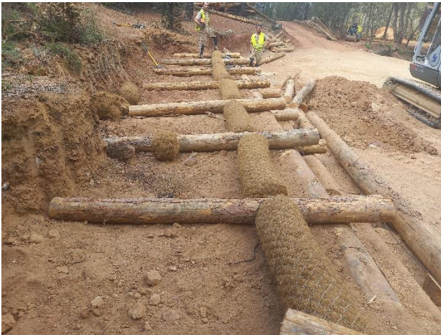
Figura 7 Construcción de los pisos intermedios del entramado.
