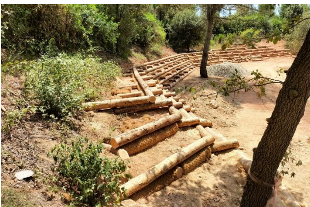
Figura 9 Construcción de entregas en cambio de pisos del entramado.
