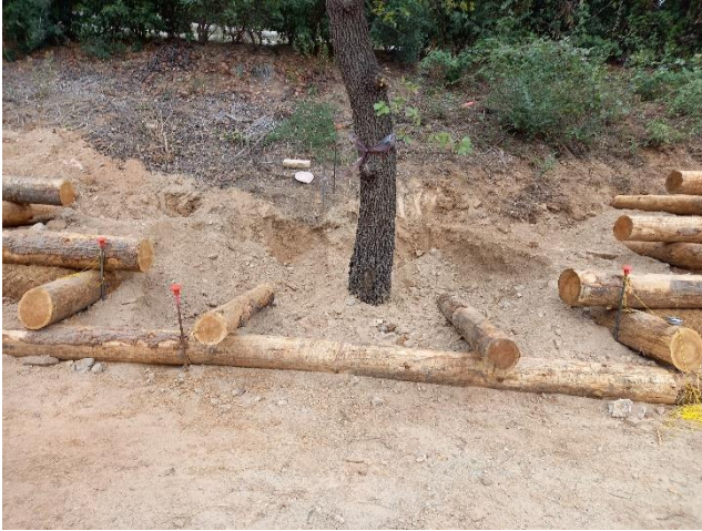
Figura 10 Encajes para ajustar el entramado al arbolado existente.
