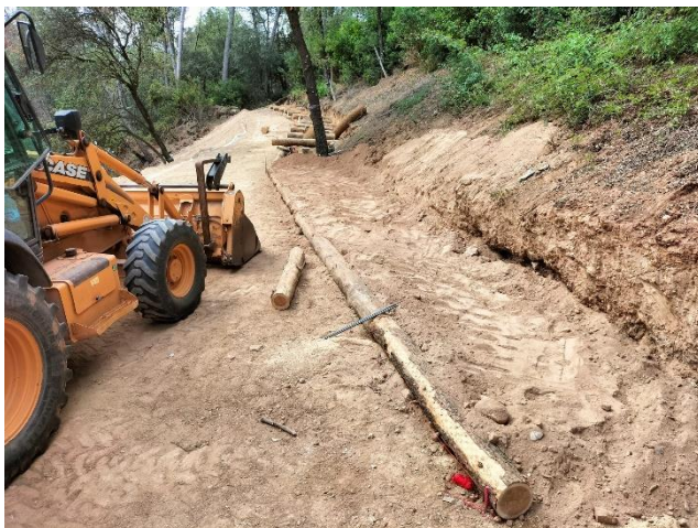
Figura 6 Construcción de la base del entramado
