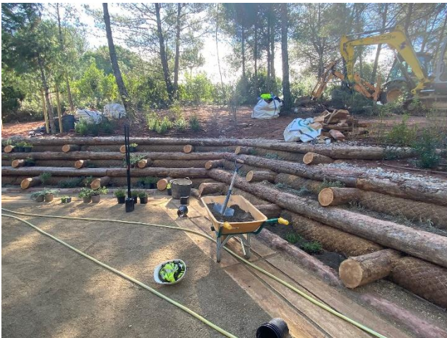
Figura 11 Plantación del entramado.
