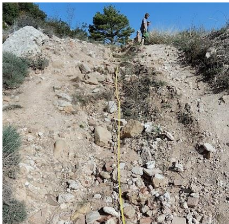
Creación de rampa de acceso al itinerario
