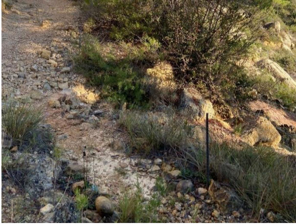
Creación de murete para consolidar el camino
