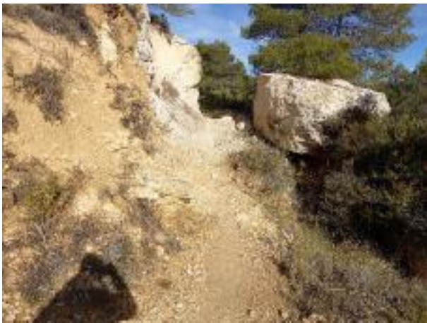
Creación de enrejado para ampliar la traza del camino
