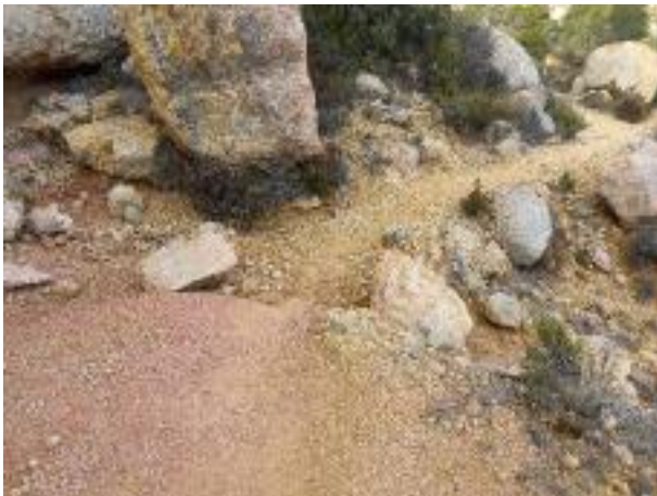
Creación de murete para consolidar el camino
