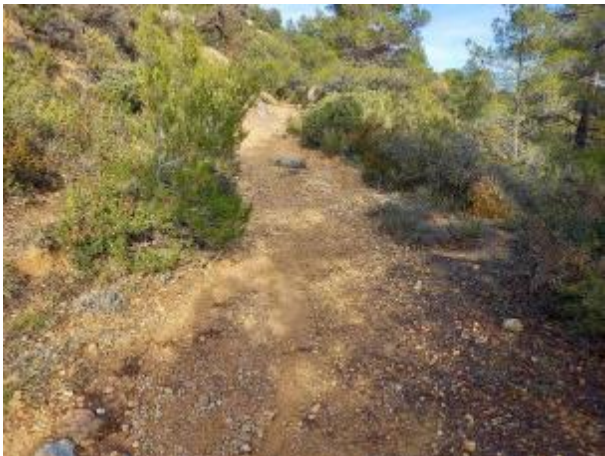
Creación de drenaje para evitar una cárcava
