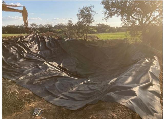
Figura 4 Imágenes durante la impermeabilización de la balsa.
