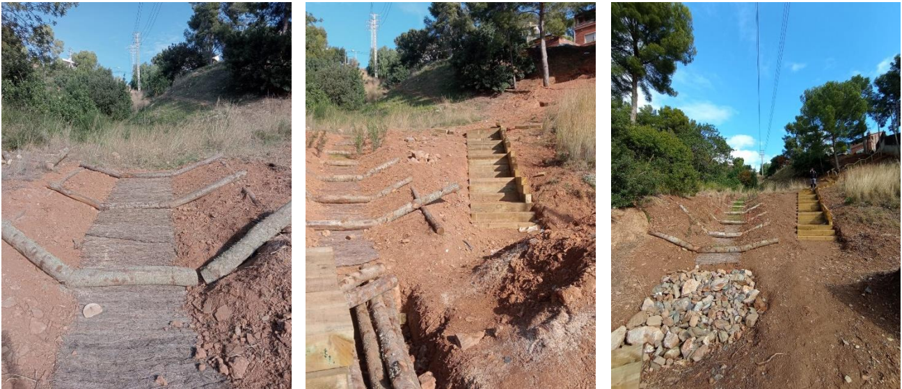
Figura 8 Imágenes de la instalación del enrejado vivo.
