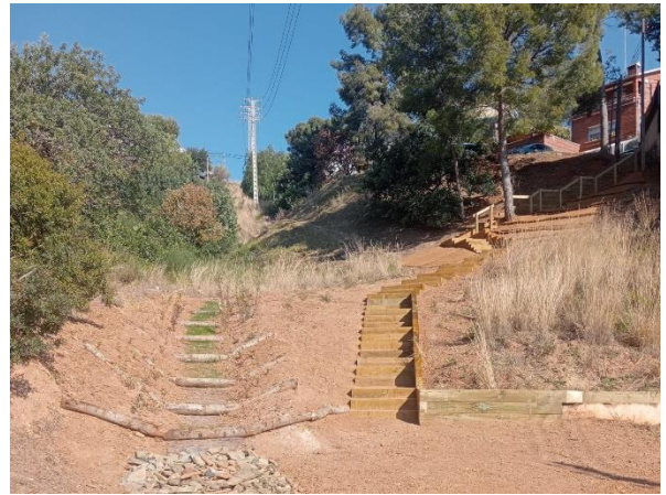
Figura 2 Después de la intervención
