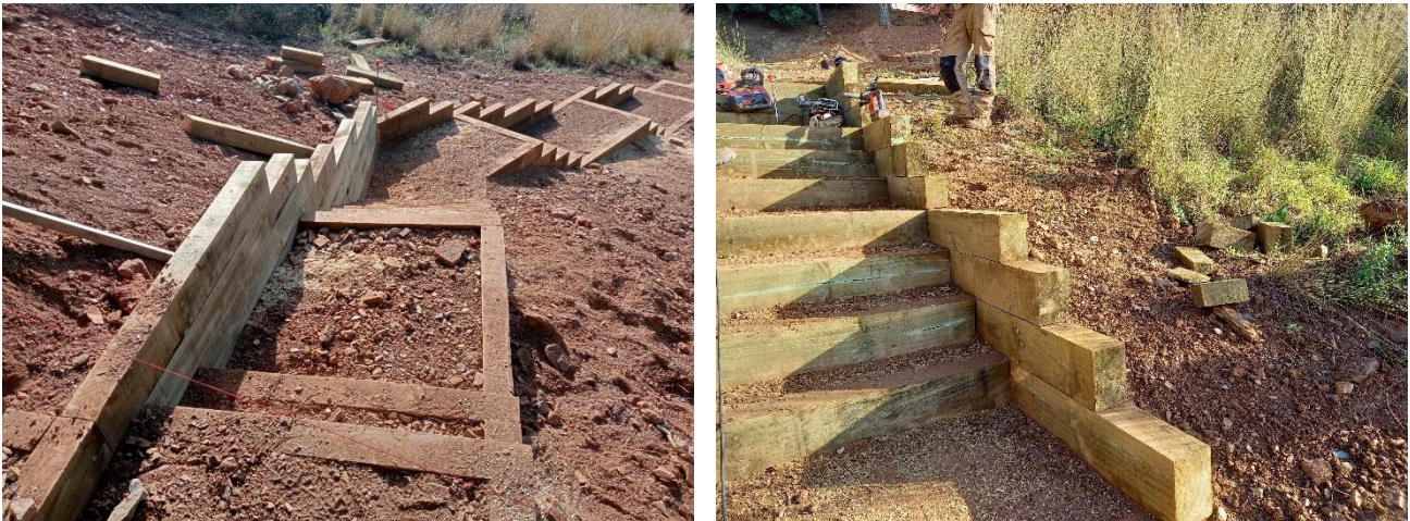
Figura 6 Imágenes de la construcción de los márgenes con ecotravesía.
