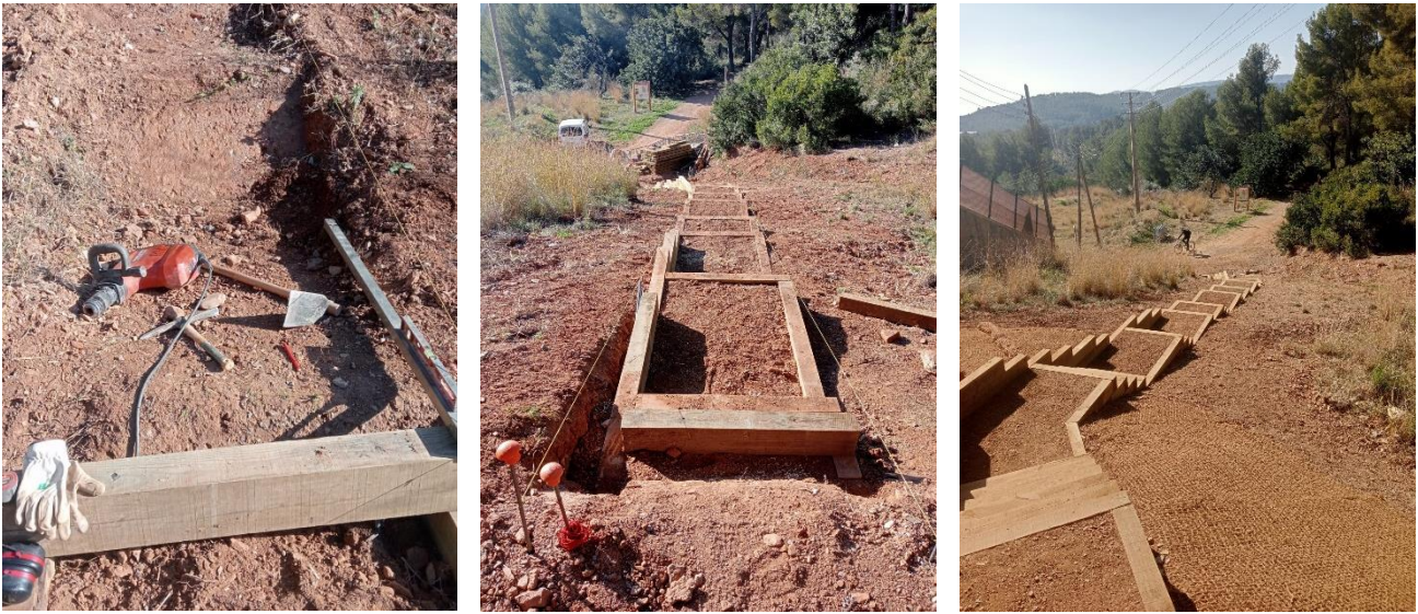
Figura 5 Imágenes de la instalación de escalones con ecotravesía.
