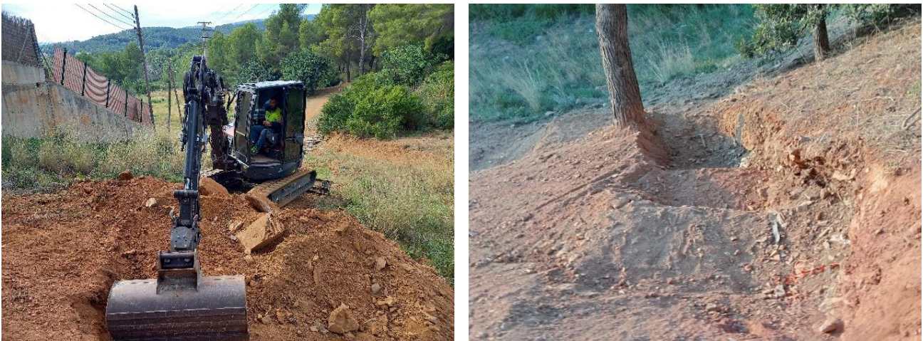
Figura 4 Imágenes de los trabajos previos con maquinaria.
