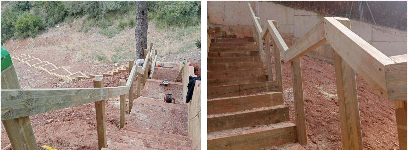
Figura 7 Imágenes de la barandilla construida.
