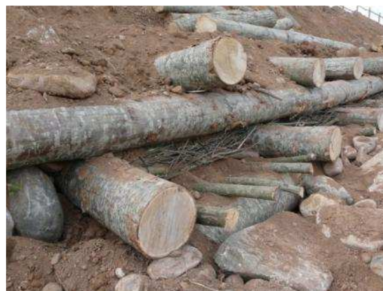
Estacas en un entramado
