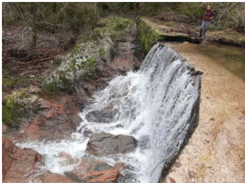
Pont de Fàbregues lock
