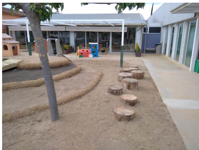
Instalación de los troncos en el patio grande, junto al arenero.
