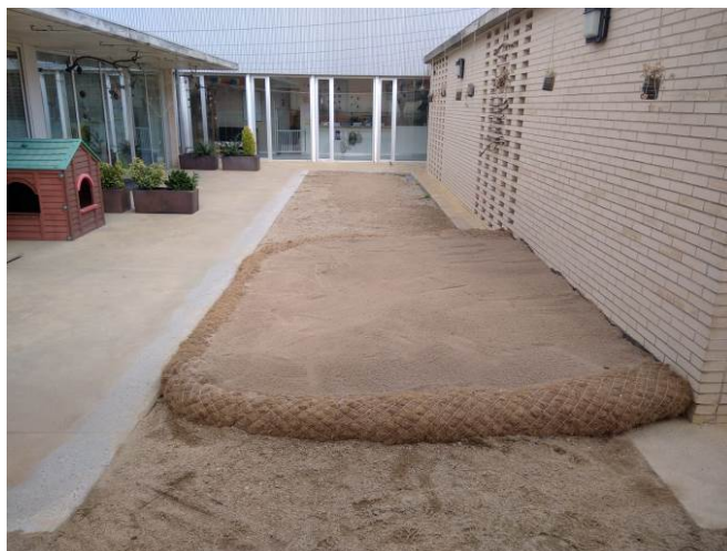
Construcción del arenero del patio pequeño.
