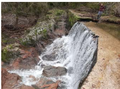
Resclosa Pont de Fàbregues
