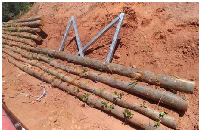
Esquema d'una estructura entramat Loricata i una imatge de col·locació en un estadi inicial de la instal·lació.
