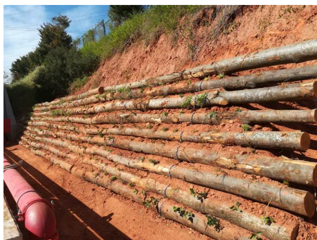
Imatges durant el procés constructiu dels entramats Loricata
