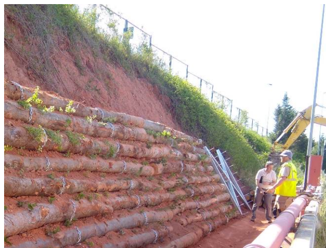
Imatges durant el procés constructiu dels entramats Loricata
