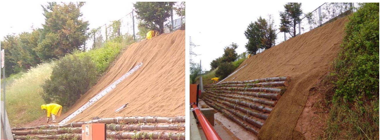
Imatges del procés d'instal·lació de la ret de coco.
