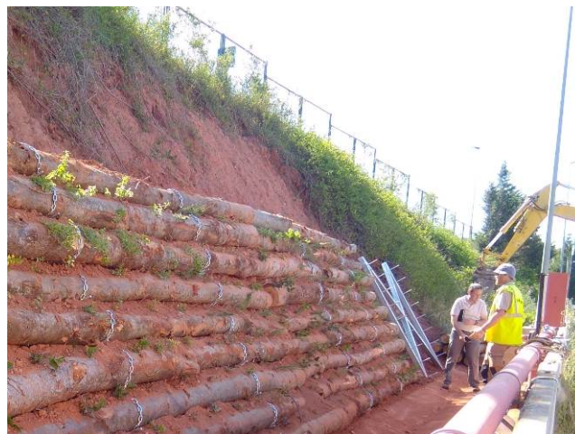
Imágenes durante el proceso constructivo de los entramados Loricata
