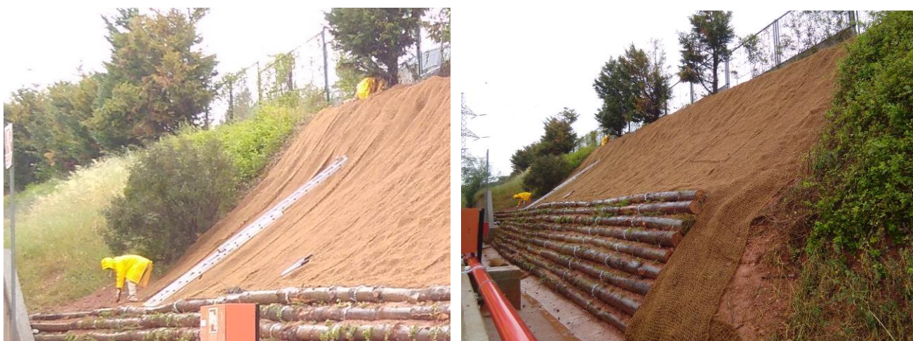
Imágenes del proceso de instalación de la red de coco.
