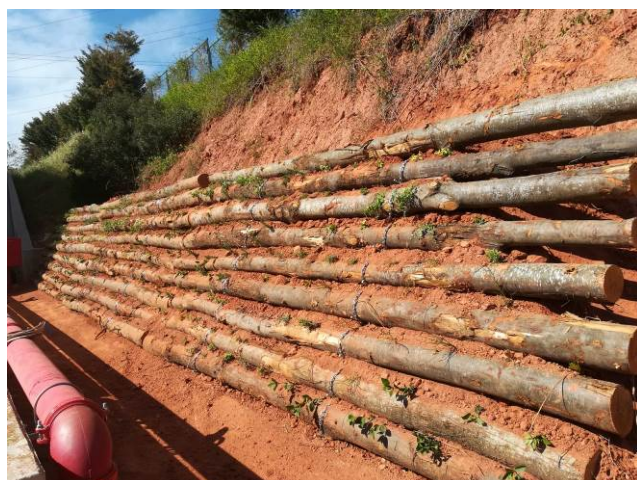
Imágenes durante el proceso constructivo de los entramados Loricata
