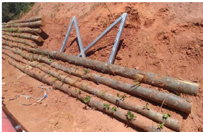
Esquema de una estructura entramado Loricata y una imagen de colocación en un estadio inicial de la instalación.
