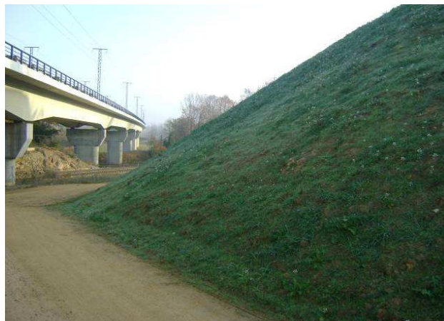
45 días después de la proyección de la HydraCX2 la vegetación cubre la totalidad de la superficie del talud, y no se observan rodales ni cárcavas.
