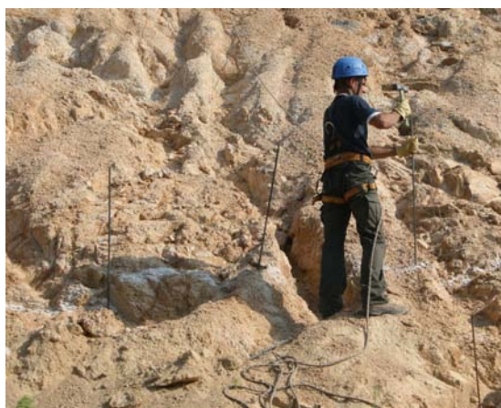
Detalle de los mismos
