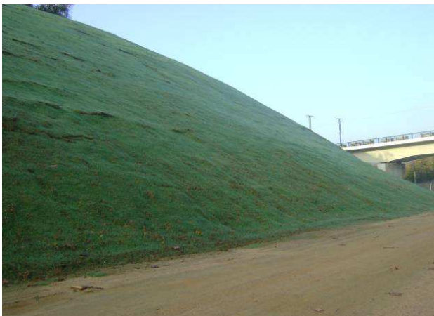
45 días después de la proyección de la HydraCX2 la vegetación cubre la totalidad de la superficie del talud, y no se observan rodales ni cárcavas.
