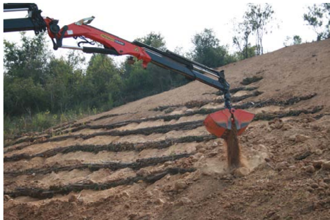
Detalle de los trabajos.
