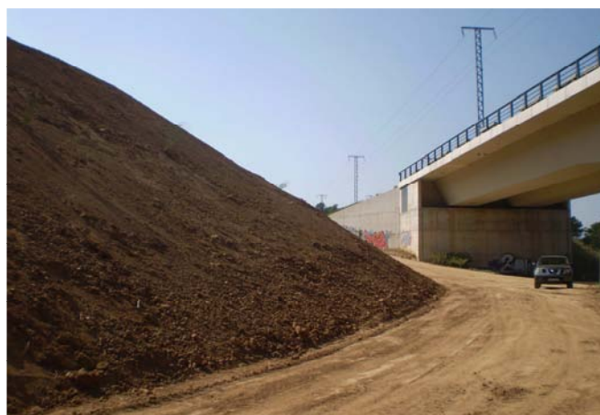
Imagen del talud con las fajas cubiertas de tierra.
