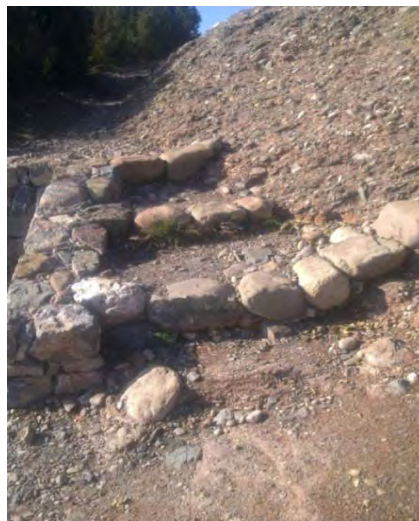
Imagen de las escaleras consolidadas
