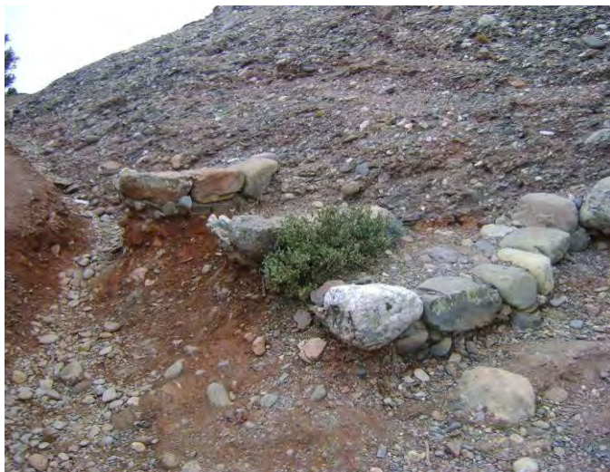
Imagen inicial antes de la consolidación de unas escaleras en el camino de Coll d'Eres
