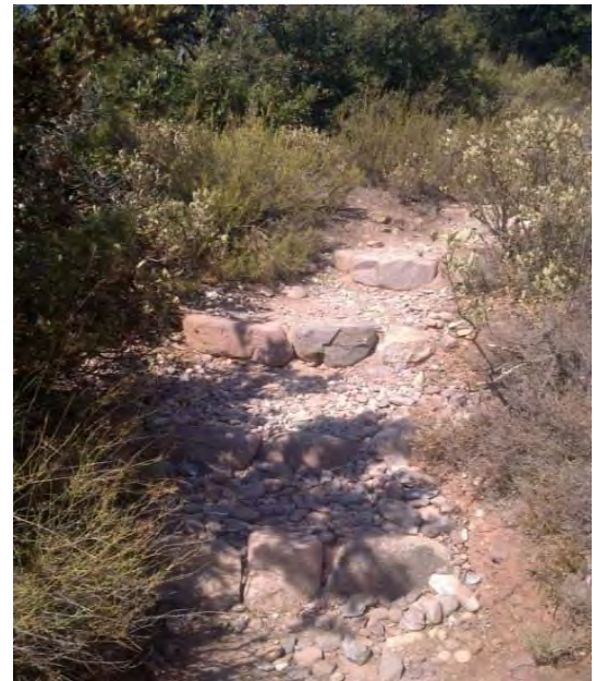
Imagen donde se han instalado dos escalones más, en la parte anterior, para consolidar la estructura y facilitar el paso
