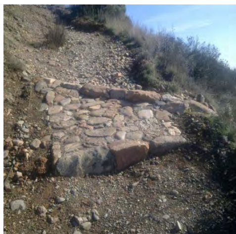
Imagen del drenaje una vez realizadas las actuaciones de mantenimiento
