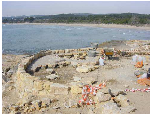
Mirador en construcción
