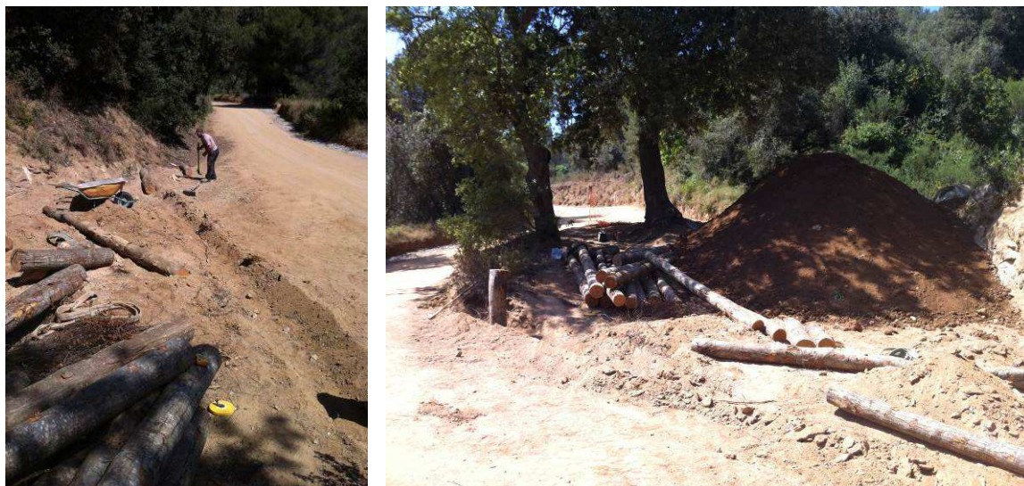
Trabajos de aporte de tierras y creación de la base de la empalizada
