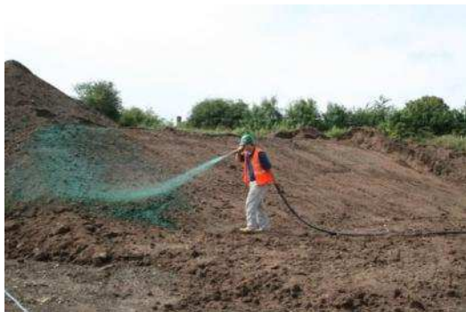
Hidromanta con proyección manual
