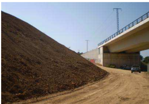
Talud antes de aplicar la hidromanta.
