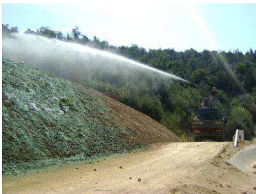
Momento de aplicación de la hidromanta.
