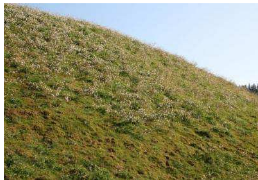
Talud 6 meses después de aplicar la hidromanta.
