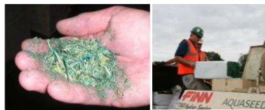
Detalle del mulch vegetal y carga en la hidrosembradora
