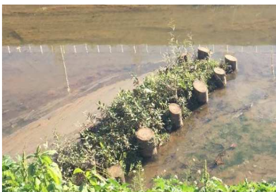
Empalizada con madeja de arbustivas recién terminada de instalar.
