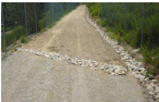
Anclaje con piedra collada en tramos de elevada pendiente
