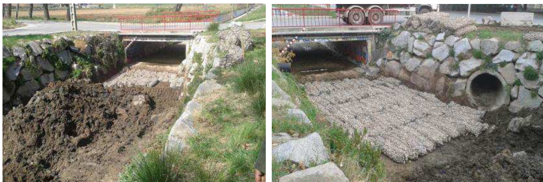
Cajón para la colocación de los gaviones flexibles tubulares - Colocación de la base
