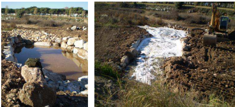
Balsa de disipación de energía a la salida de una depuradora en una obra ejecutada por Naturalea.
