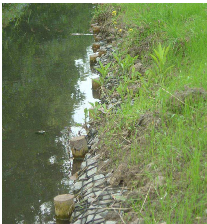
Rock Rolls instalados en un margen. Fuente: Oekön
