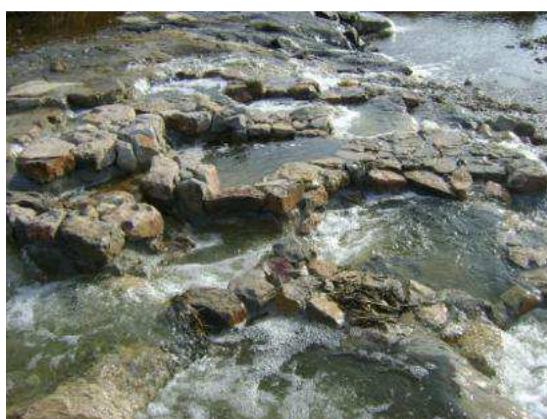
Rápidos con escollera (Burgos) y zona con una escalera de peces integrada (Granollers). Ambas intervenciones realizadas por Naturalea
