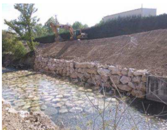
Rápidos con escollera (Burgos) y zona con una escalera de peces integrada (Granollers). Ambas intervenciones realizadas por Naturalea
