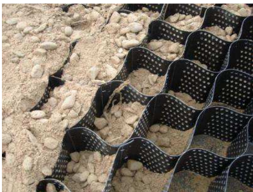
Detalle de las geoceldas
