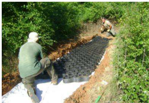
Proceso de instalación de las geoceldas
