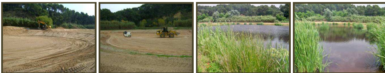
Construcción y resultado de una balsa impermeabilizada con arcillas.
