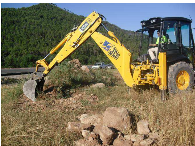
Retroexcavadora retirando los restos de la antigua barraca.
