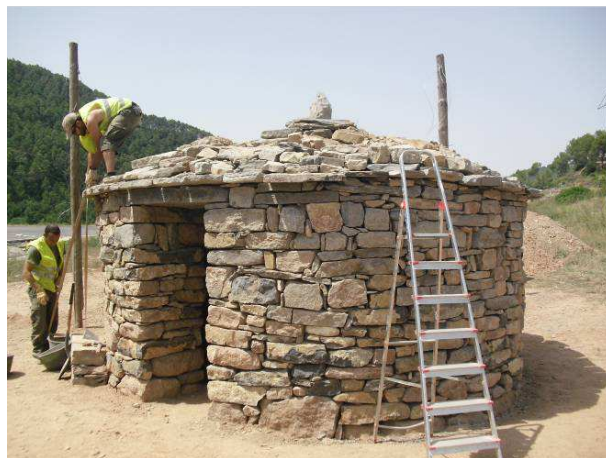
Barraca finalizada pendiente de colocar la tierra
