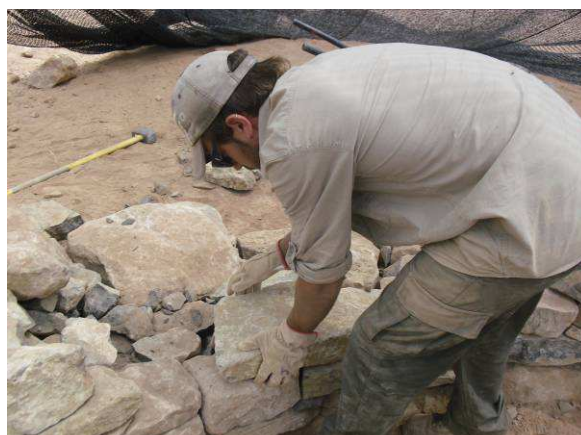
Colocación de piedra. Se ve claramente el ripio en el interior del muro.
