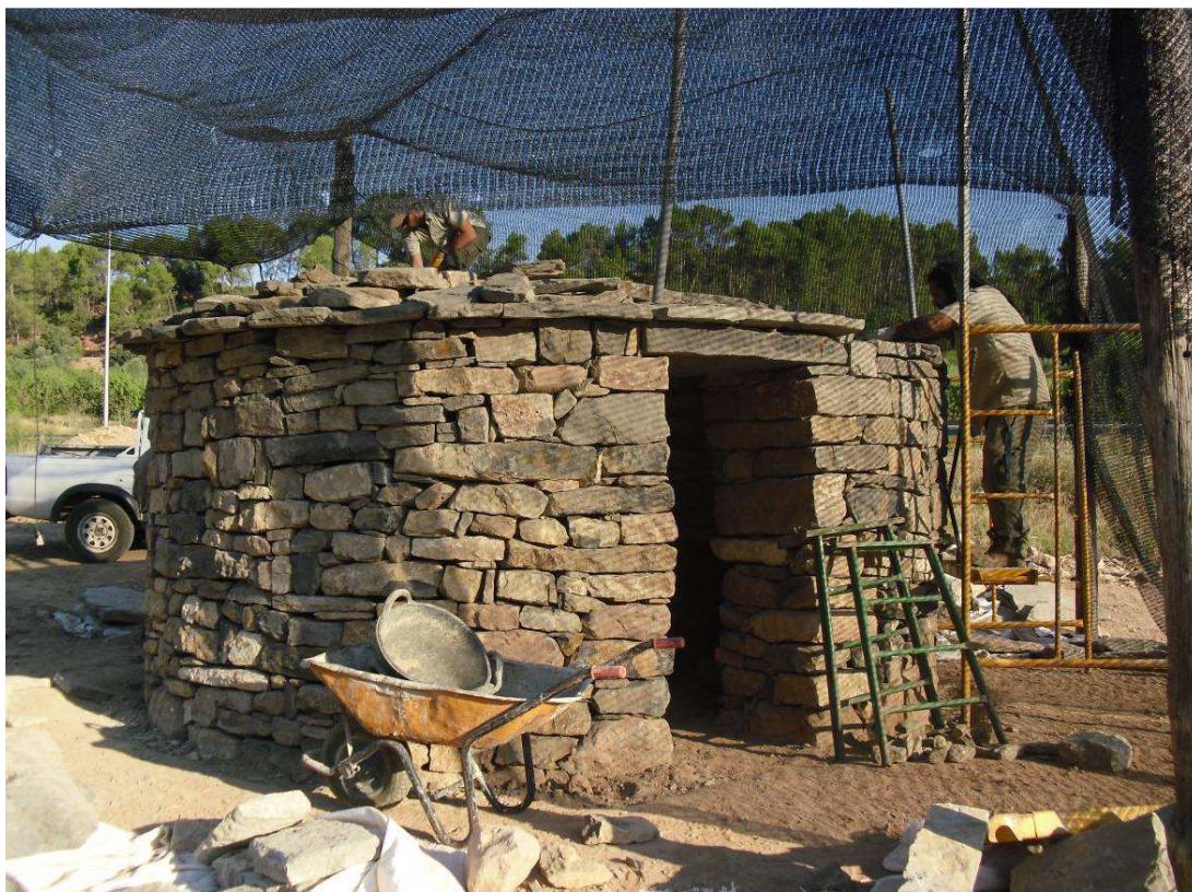
Proceso de construcción de la barraca
