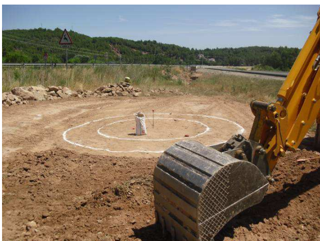
Retroexcavadora terminando de nivelar y comenzando la realización de la zanja.
