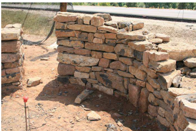
Muros durante el proceso de construcción.
