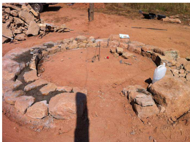
Base de la barraca hormigonada y con la primera línea de piedras collada.
