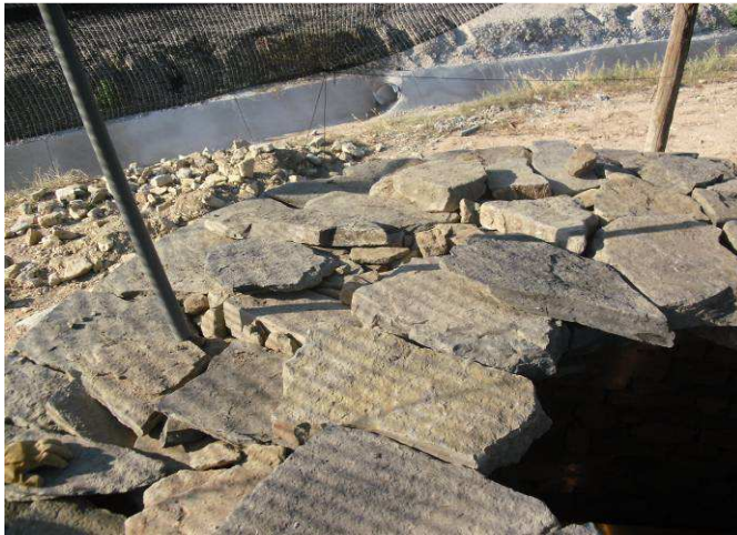
Proceso de construcción del techo
