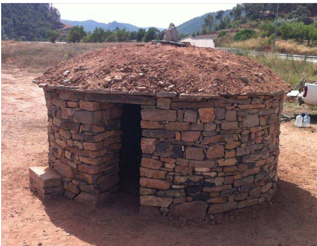
Barraca finalizada. Se ha colocado la tierra que permitirá sellar el espacio entre piedras, evitar filtraciones, consolidar la estructura y mantener la temperatura en el interior.
