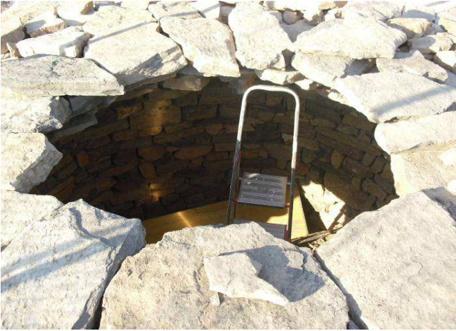
Proceso de construcción del techo visto desde la parte superior y la inferior. Se puede observar la disposición milimétrica de losas para ir tapando el agujero a la vez que hacen contrapeso para que la estructura aguante por sí sola.
