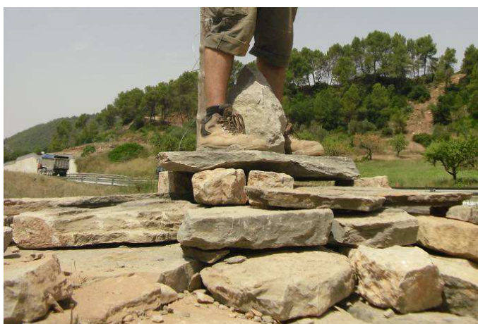
Detalle de la chimenea
