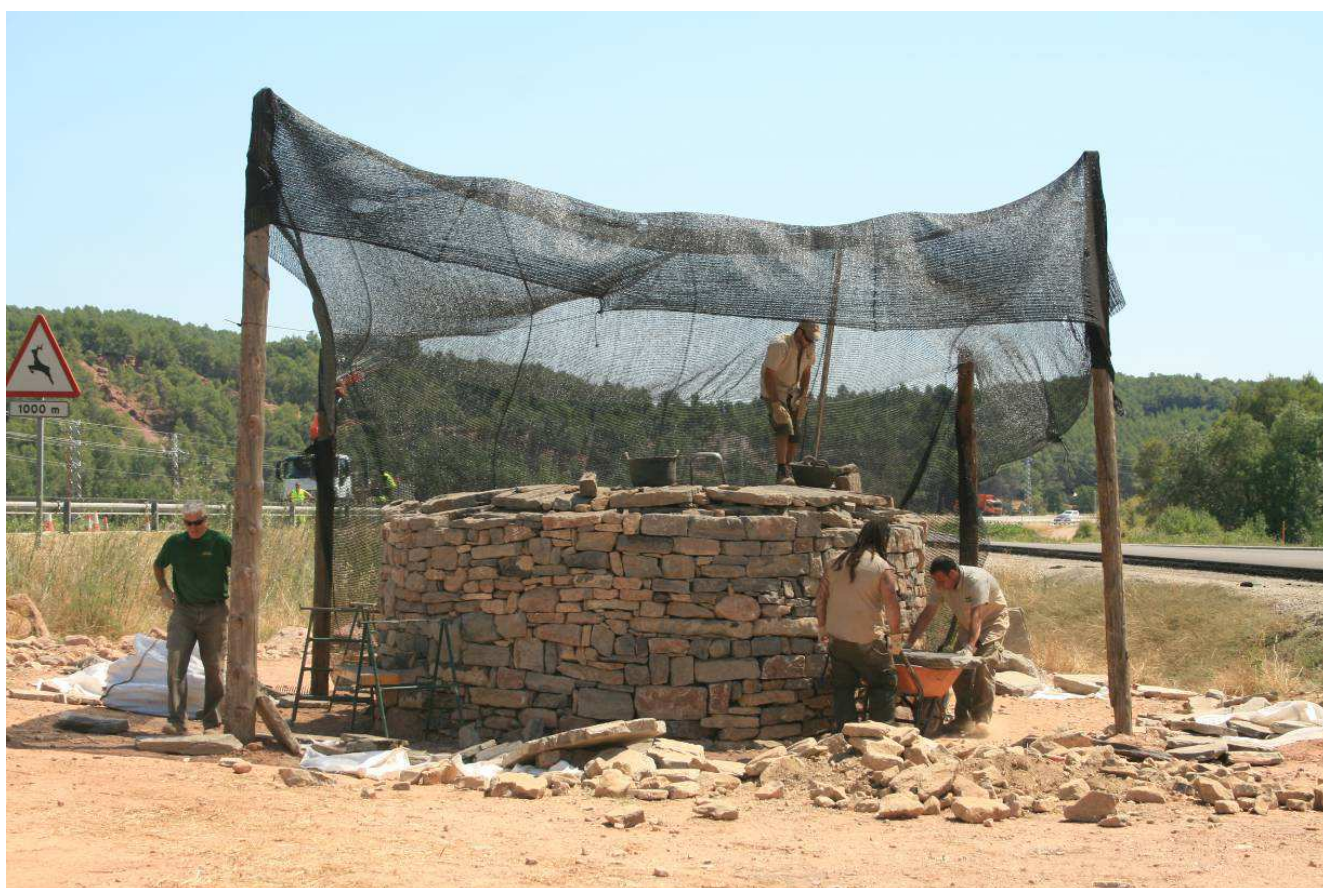
Proceso de construcción de la barraca
