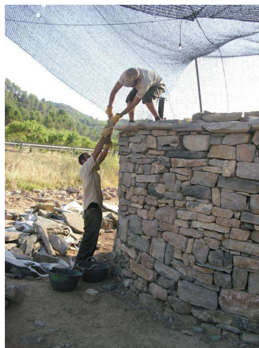
Apoyo desde tierra para confeccionar el techo
