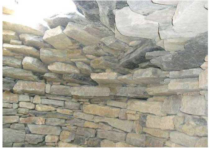
Proceso de construcción del techo visto desde la parte superior y la inferior. Se puede observar la disposición milimétrica de losas para ir tapando el agujero a la vez que hacen contrapeso para que la estructura aguante por sí sola.
