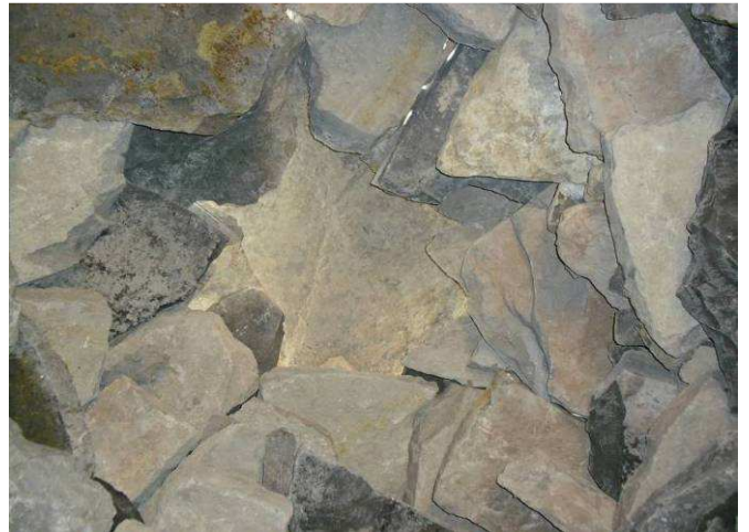
Imagen del techo finalizado. Las grietas de luz que se ven son la apertura de la chimenea.
