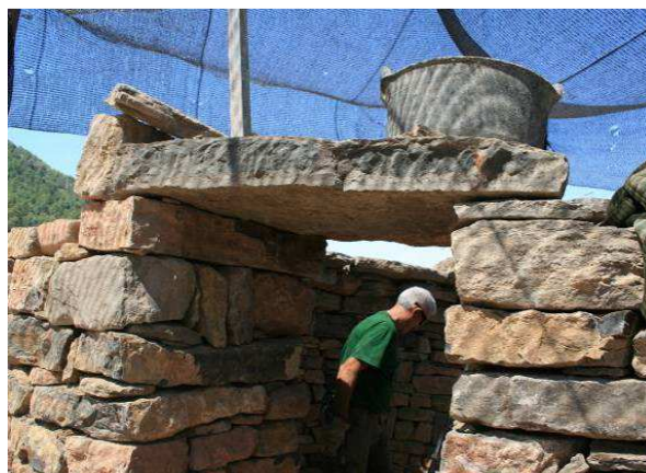
Dintel de la puerta colocado.
