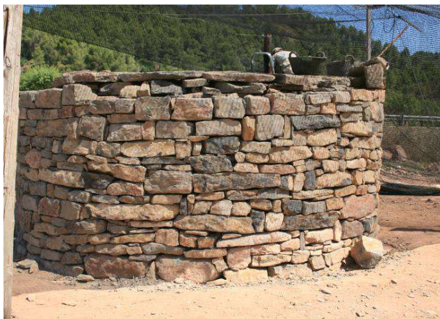
Inicio de la construcción del techo
