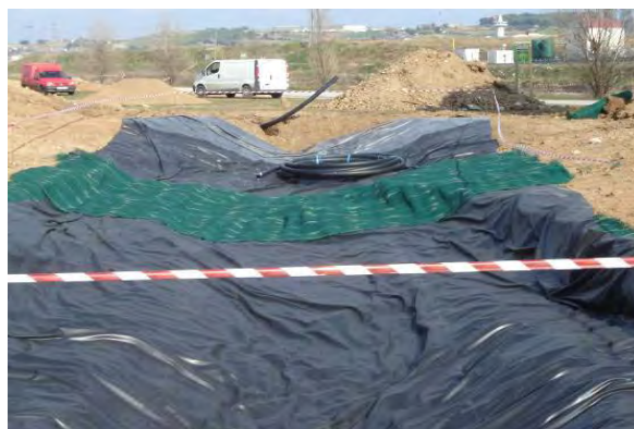
Impermeabilización de la balsa
