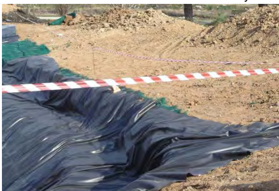
Impermeabilización de la balsa
