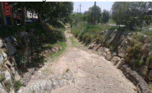
Lecho de gaviones Rock roll en el cauce
