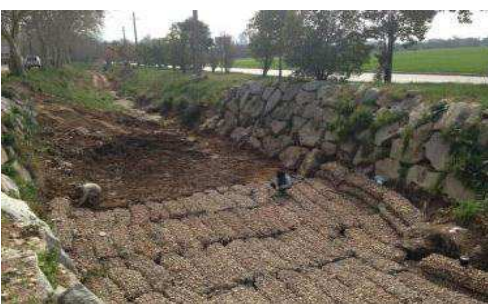
Lecho de gaviones Rock roll en el cauce
