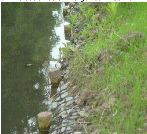
Protección de un margen con Rock roll
