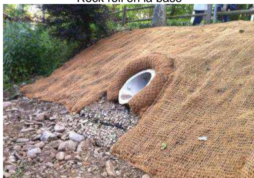
Salidas de colectores protegidas con gaviones Rock roll en la base
