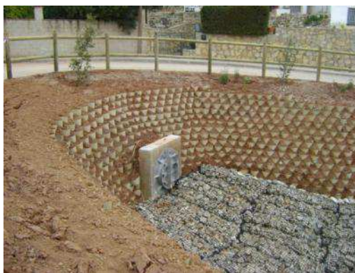
Salidas de colectores protegidas con gaviones Rock roll en la base
