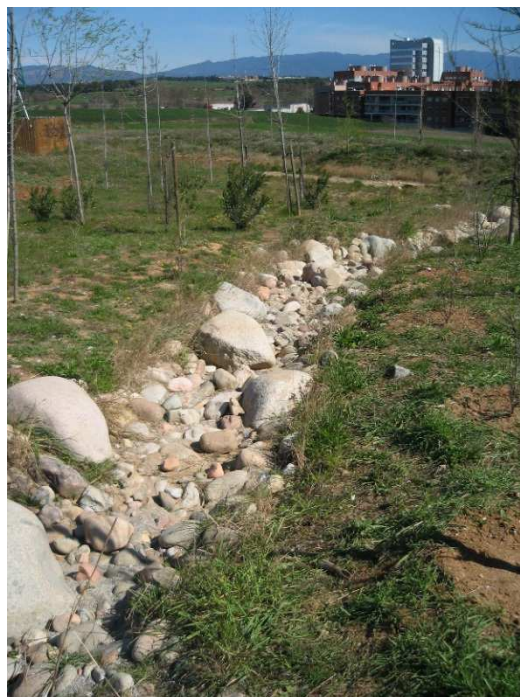
Parc dels Pinetons (Mollet del Vallès). Sobreeixidor d'una bassa de reg que acaba en una depressió per recarregar l'aquífer.
