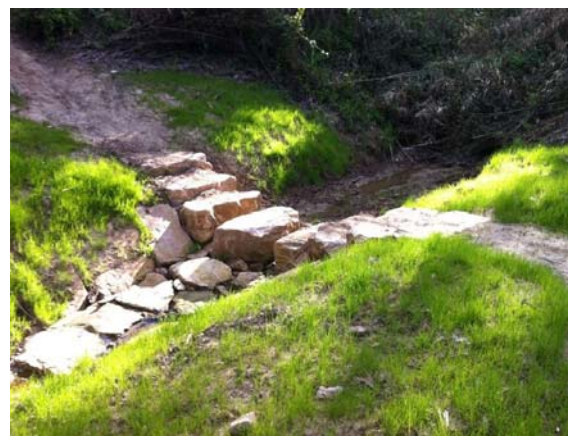
(Totes les imatges són execucions de Naturalea)
