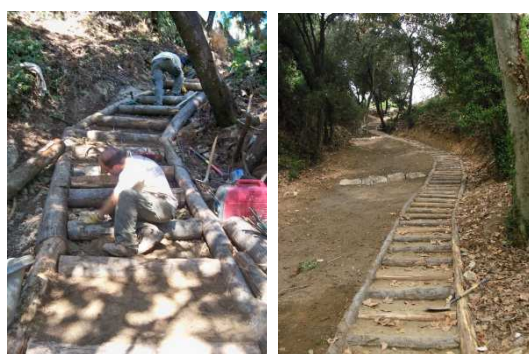
Collat dels diferents troncs amb barres corrugades
