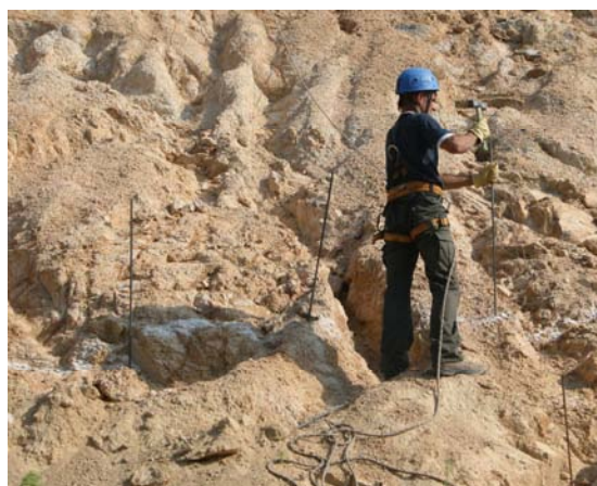
Detall dels treballs inicials.
