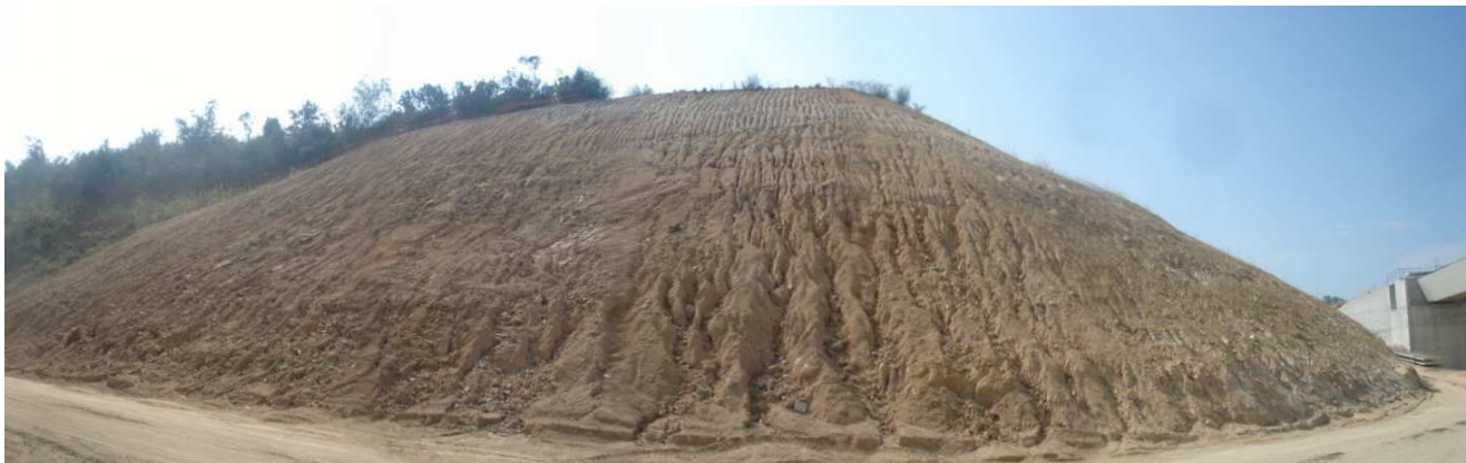
Imatge general de la situació inicial del talús.
