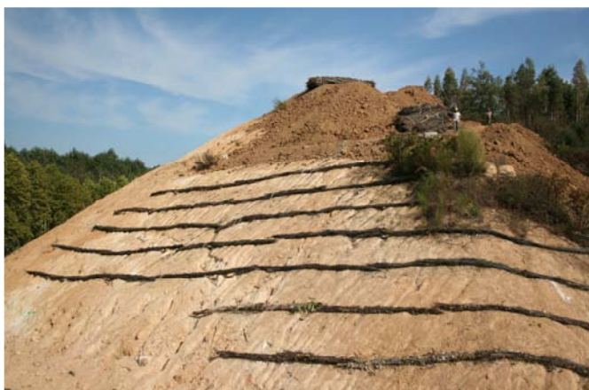
Vista general de la instal·lació de feixines de branca seca.
