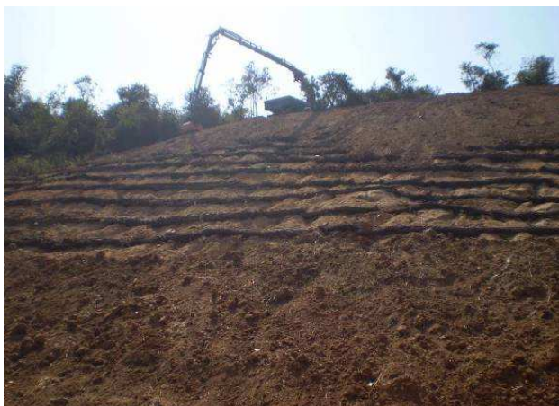
Vista general dels treballs d'aportació de terres
