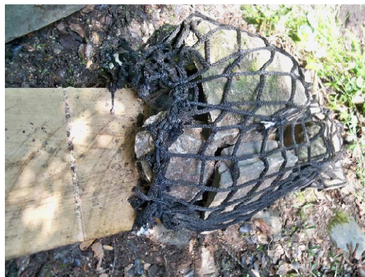
Fixació de la base d'una rampa amb gabió flexible
