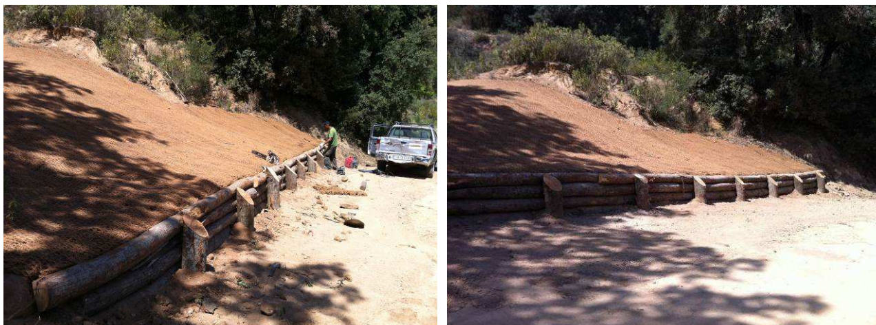
Treballs d'acabats amb la protecció del talús amb ret de coco
