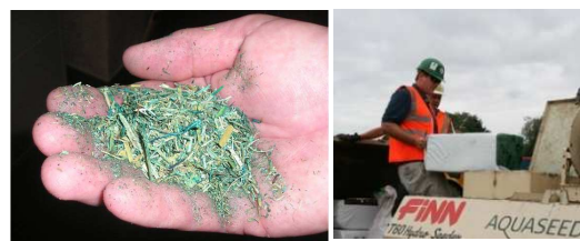
Detall del mulch vegetal i càrrega a la hidrosebradora
