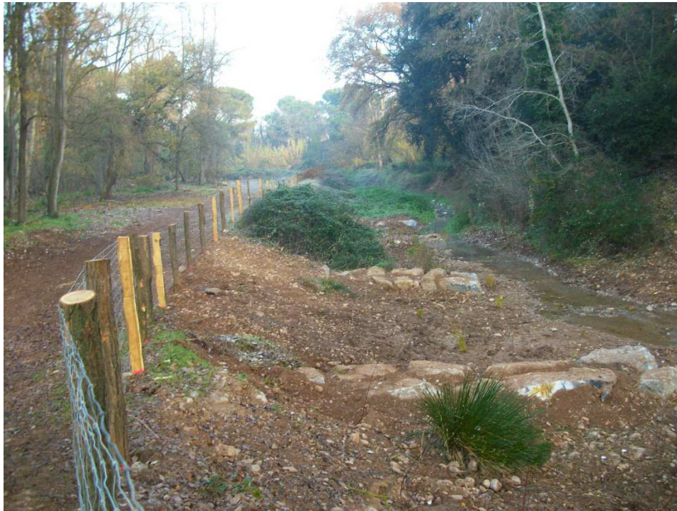
Serie de espigons per a suavitzar una corba. Riera de Caldes. Palau de Plegamans
