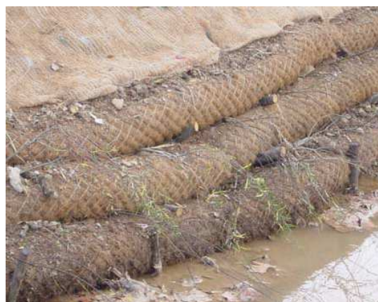
Enfeixinat de rotlles estructurats tipus Fiber Roll
