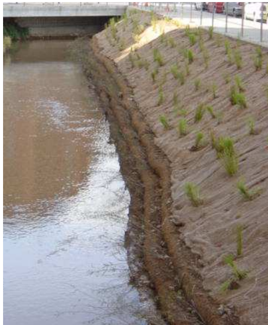
Enfeixinat de rotllos estructurats tipus Fiber Roll just acabat d'instal·lar i després d'uns mesos.
