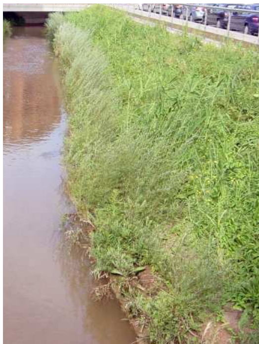
Enfeixinat de rotllos estructurats tipus Fiber Roll just acabat d'instal·lar i després d'uns mesos.
