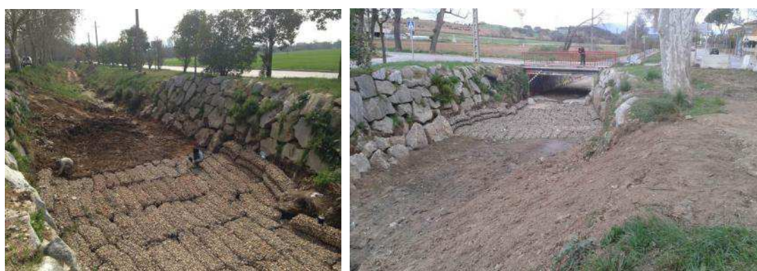
Entrega als marges amb la base d'escullera i lligat dels gabions entre ells
