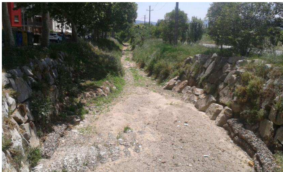
Imatge de la zona després de l'execució i de pluges. El llit de gabions ha quedat cobert pels sediments.
