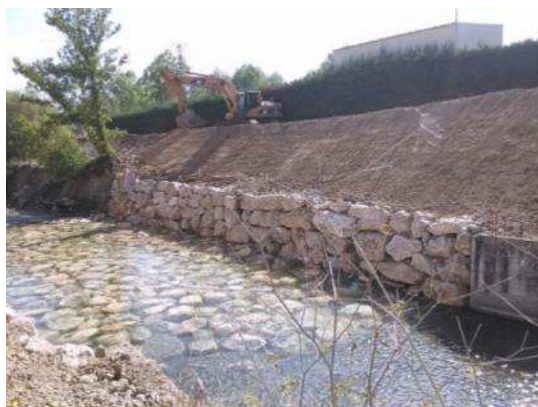
Ràpids amb escullera (Burgos) i zona amb una escala de peixos integrada. (Granollers). Intervencions realitzades per Naturalea
