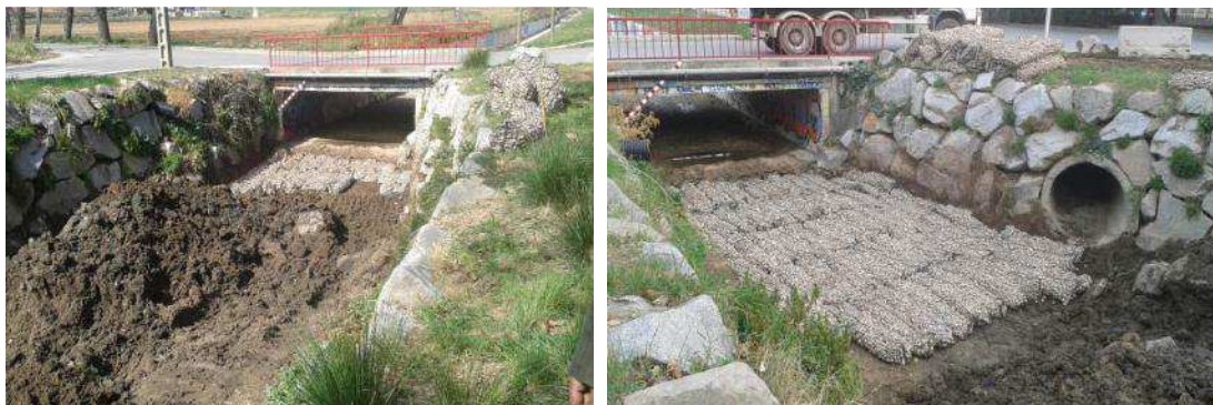
Calaix per a la col·locació dels gabions flexibles tubulars – Col·locació de la base
