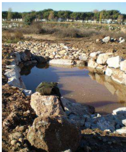
Bassa de dissipació d'energia a la sortida d'una depuradora. Obra executada per Naturalea.
