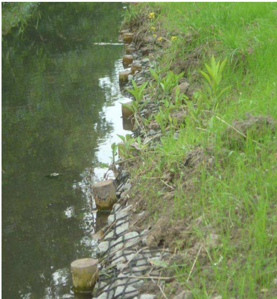
Rock Rolls instal·lats en un marge. Font: Oekön
