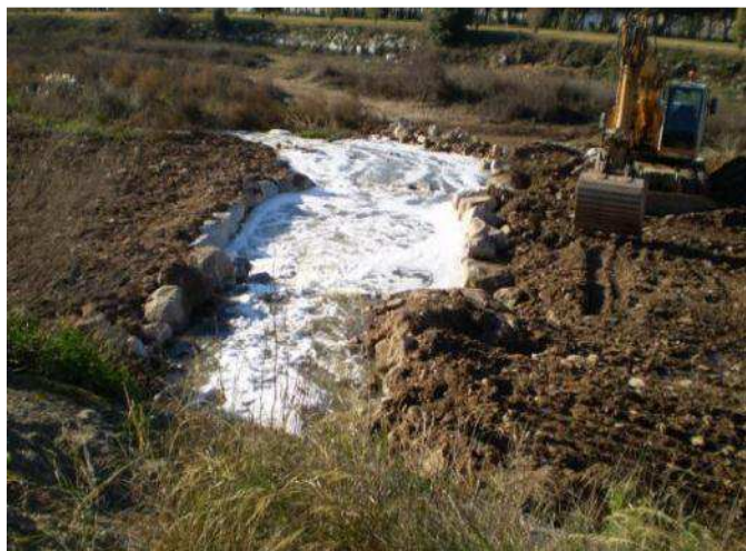
Bassa de dissipació d'energia a la sortida d'una depuradora. Obra executada per Naturalea.
