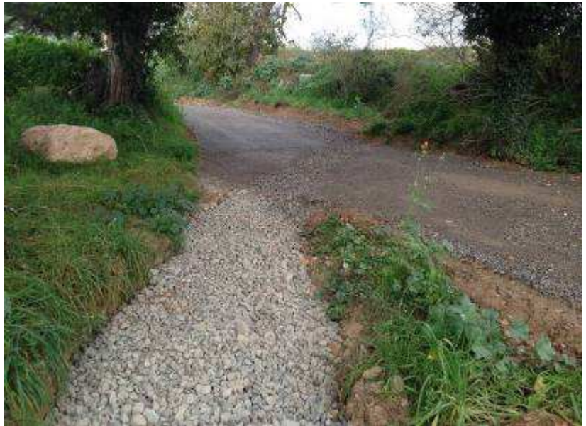
Sortida del drenatge abans i després, i detall de l'empedrat que rep l'aigua.
