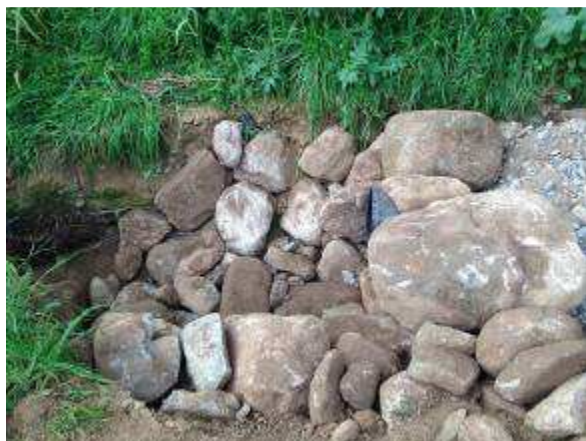
Sortida del drenatge abans i després, i detall de l'empedrat que rep l'aigua.
