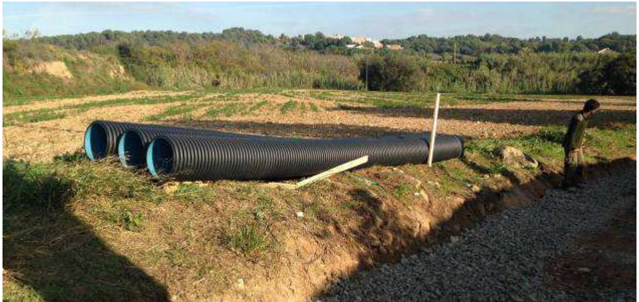
Mostra dels tubs drenants que permetran una ràpida circulació de l'aigua en els trams baixos on aquesta s'acumula.
