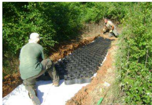
Proces de instal·lació de les geocel·les
