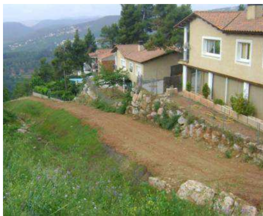
Camí ja estabilitzat amb geocel·les
