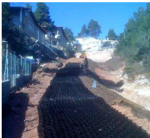
Instal·lació de les geocel·les.
