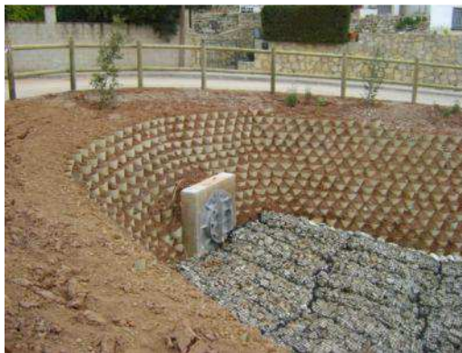
Sortides de col·lectors protegides amb gabions Rock roll a la base
