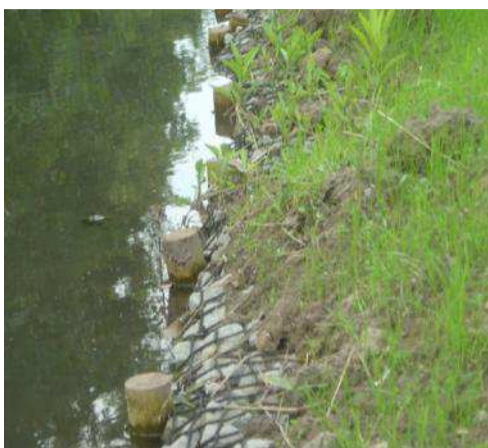
Protecció de marges amb gabions Rock roll
