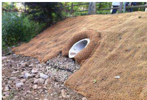
Sortides de col·lectors protegides amb gabions Rock roll a la base
