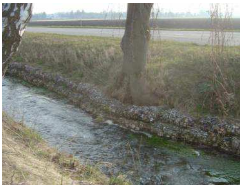
Protecció de marges amb gabions Rock roll
